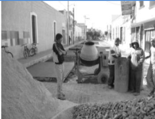
La avenida Juárez es pavimentada dentro del programa de obra directa del municipio de Tarandacuaao.
